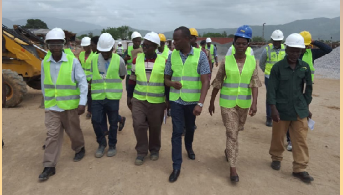
Naibu Waziri wa Nishati, Wakili Stephen Byabato (wa Tatu kulia) akikagua kazi za ujenzi wa kituo kipya cha kupoza umeme pamoja na laini mpya za kusambaza umeme kinachojengwa wilaya ya Ifakara mkoani Morogoro.
